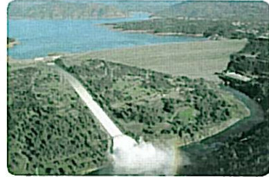
Lake Oroville Spillway
